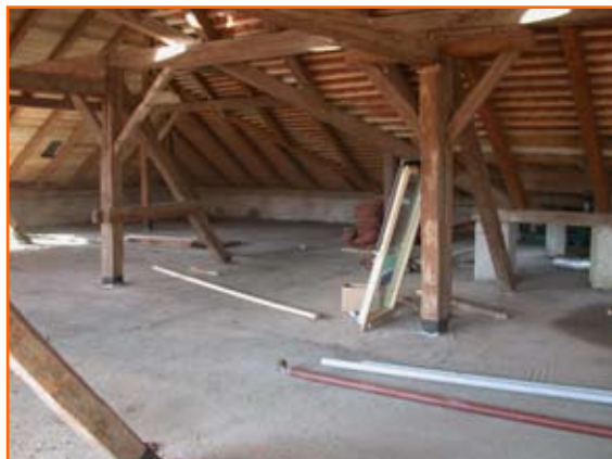
Nova betonska plošča.
